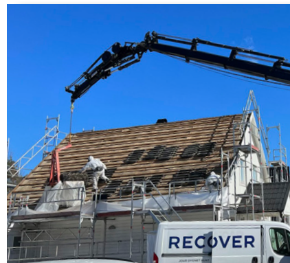
Den gamla takbeläggningen, innehållande asbest, avlägsnas säkert
