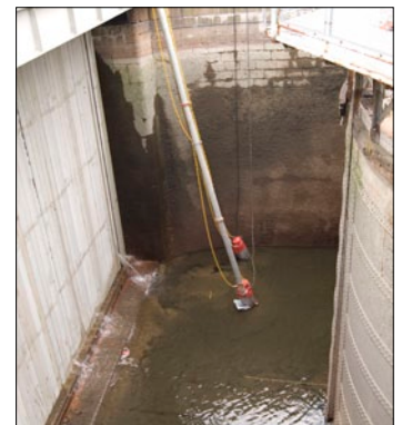
Två Matadorpumpar håller undan läckvatten innanför en temporär slussport i Lilla Edet.
