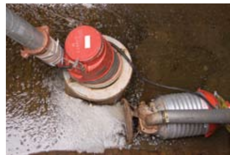
Nedre slussarna i Trollhättan, två Matadorpumpar håller undan läckvatten innanför en temporär slussport.
